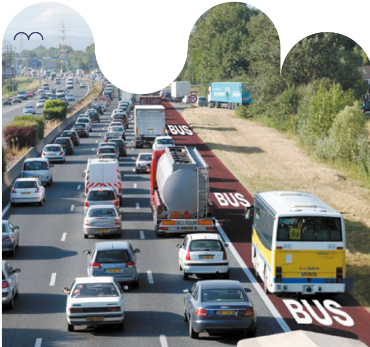
Voie réservée partagée sur l'A48 en direction de Grenoble © SMTc
