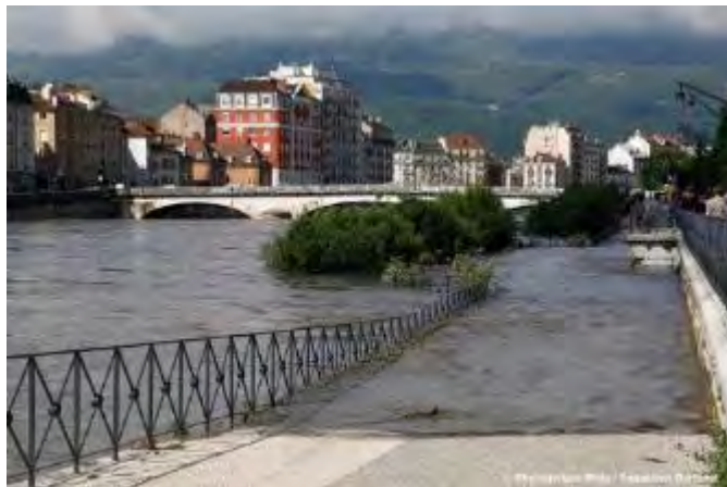
Crue de l'Isère à Grenoble Quai Perrière
