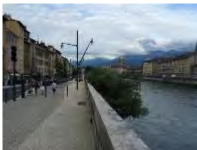
Grenoble, les quais de l'Isère aménagés : partage entre cycles et piétons par un traitement de sol pensé pour construire un espace public de qualité
