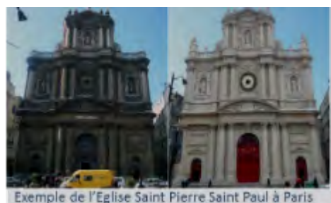
Exemple de l'Eglise Saint Pierre Saint Paul à Paris
