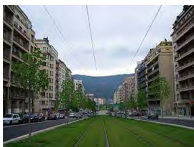
Grenoble, cours de la Libération : engazonnement des voies de tramway et partage entre cycles et voitures pour un apaisement de la circulation
