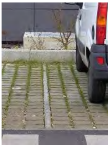
Revêtements poreux : stationnement enherbé au Fontanil (gauche) et dans la ZAC des Ruires à Eybens (droite)
