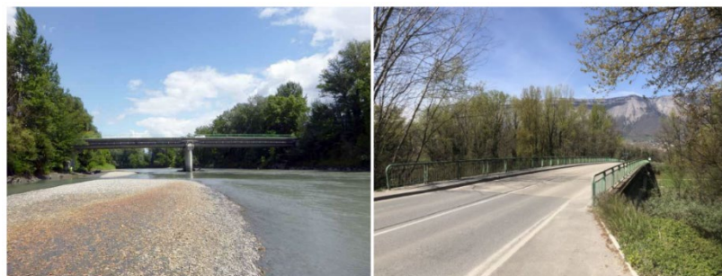
► Pont de La Bâtie Photos INGEROP
